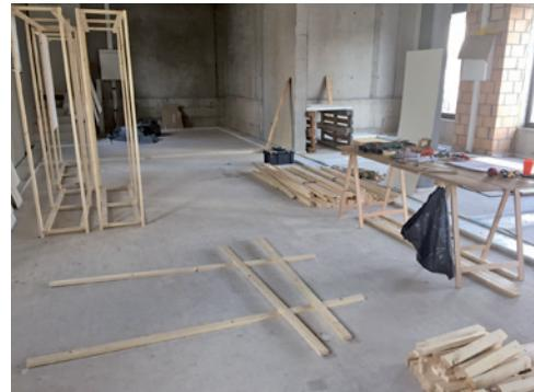
Zusammenbau der 10 Module aus 120 Dachlatten
